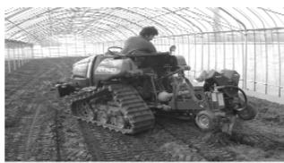
写真-2 土層改良作業(34PS)
