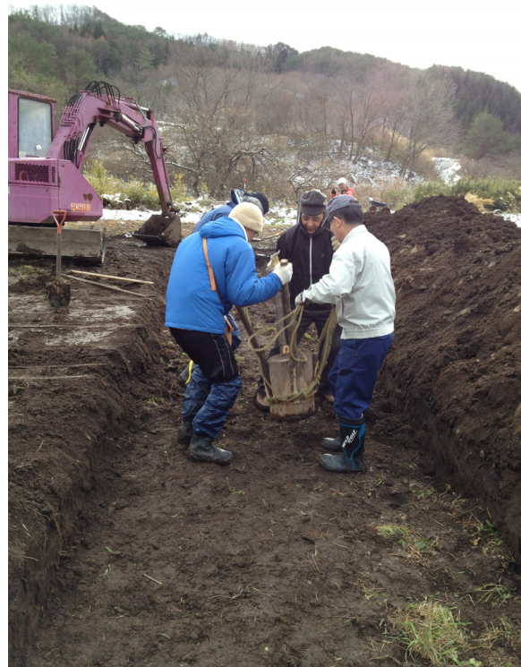
Photo-1 汚染土の埋設作業(2012.12.1)
