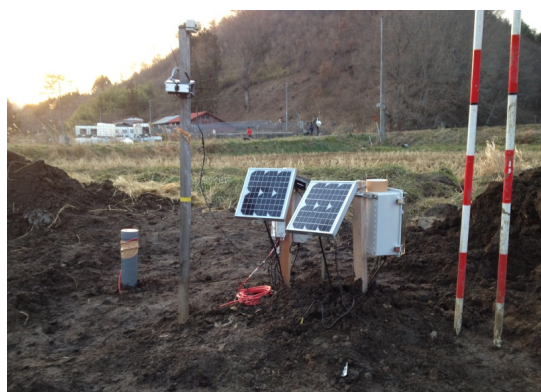
Photo-2 モニタリング機器の設置
