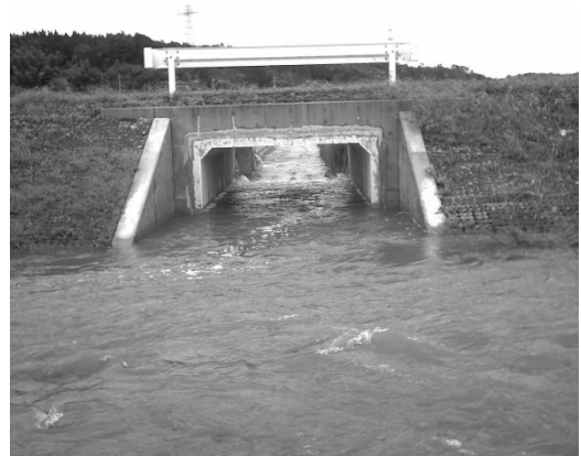
図2 水位上昇時の落差の状況 Aspect of drop a work when water level rose
