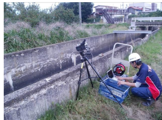
図2 赤外線計測状況(パッシブ法)
