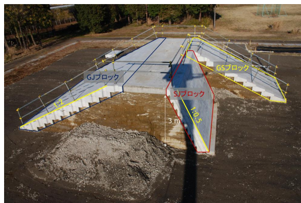
写真－2 施工確認試験で築造した堤防
