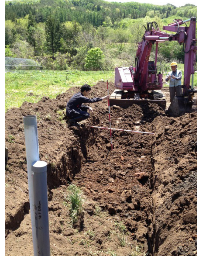
Fig. 1 汚染表土の埋設と観測孔の設置
