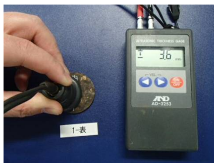
図-4 板厚測定状況
