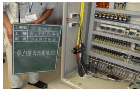
写真 1 電力量測定状況
