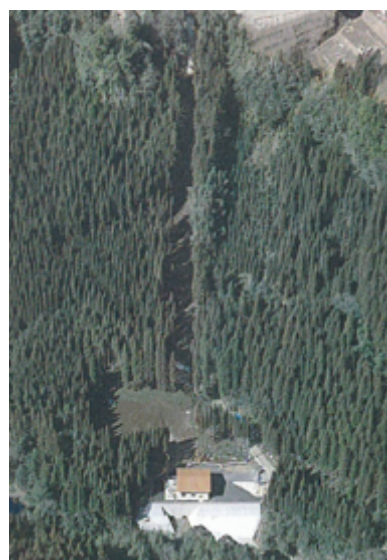
写真2 長谷緒井発電所の外観
