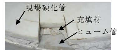
図 3 エアミルクの充填状況 Filling condition of air milk
