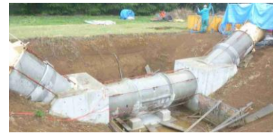
図 1 実験模型の全体写真 Overall view of the test model
