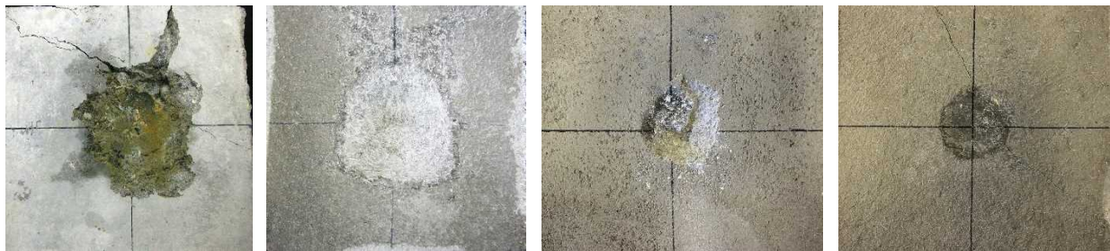
C1 (130回でひび割れ)
