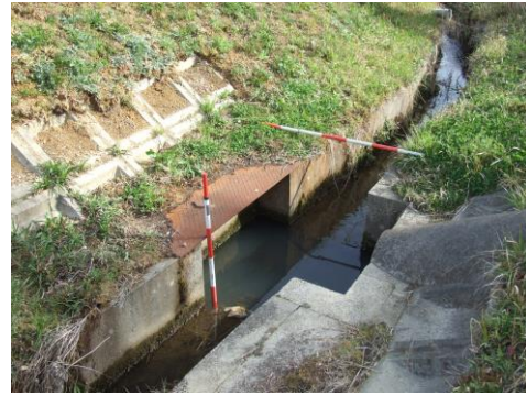
写真3 天下溝の放水工 (2017年4月10日撮影)
