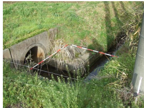
写真4 鍛冶屋町の排水路1 (2017年4月10日撮影)
