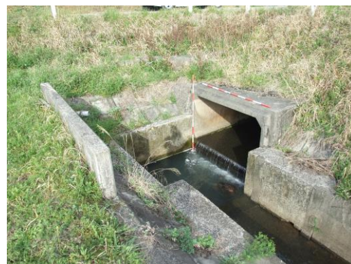
写真5 鍛冶屋町の排水路2 (2017年4月10日撮影)
