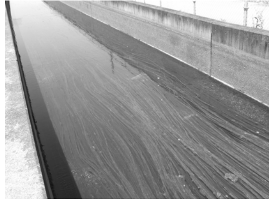
写真1 水路全体に発生した糸状性藻類 Filamentous algae growing in open channel
