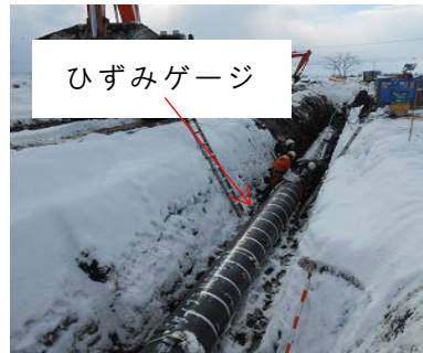
図. 寒冷地での実証試験 (EF 継手施工 長期測定準備)
