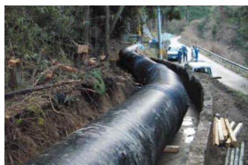
図. PE-GF 管の施工例
