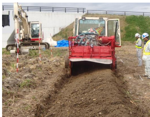
写真-4 施工状況
