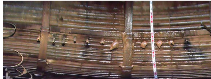
図4 集水ボーリング孔口の状況
