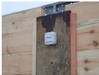
写真-2 監視状況（土留め）
