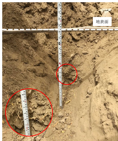
写真 1 疎水材充填の様子
