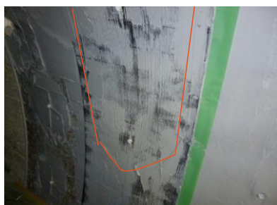
写真-2 FBG センサ設置状況 Photo-2 installation status of FBG sensor
