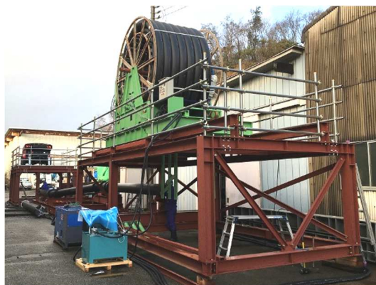
図3 PEライナの試験施工機器配置状
