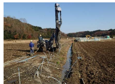
写真1 管水路の耐震補強工事例
