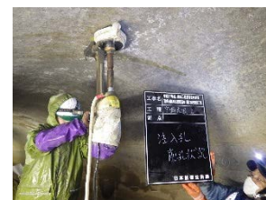
写真2 トンネル裏込注入例
