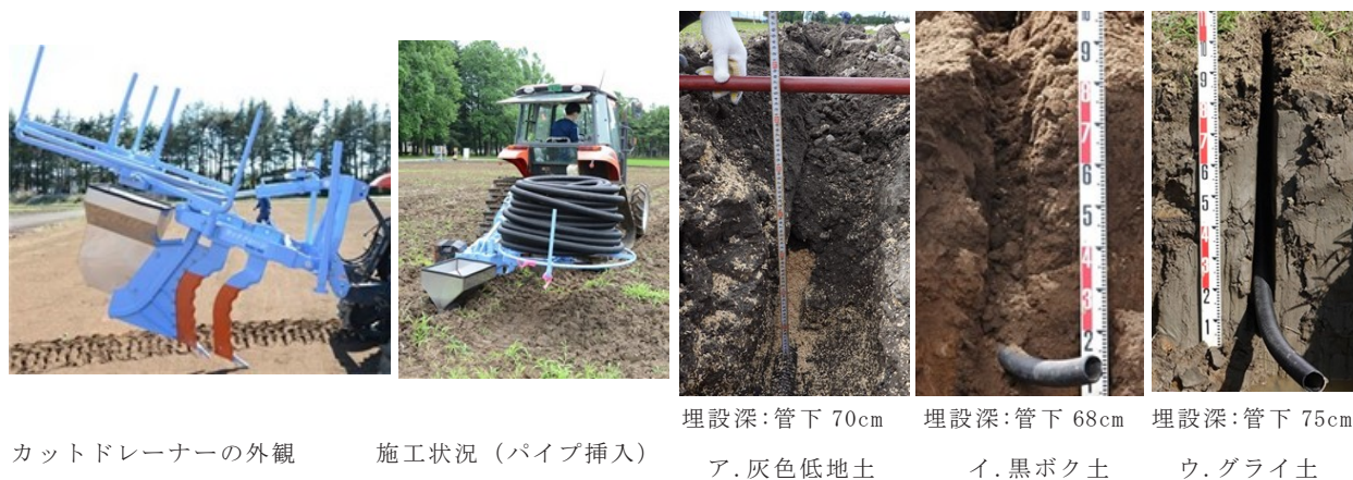
Photo 1 本暗渠機の外観と施工状況
