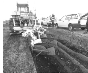
写真-1 反転均平工法 プラウの反転状況
