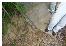
写真-1 洪水吐左岸側 (H25.6.17, 水土里ネット島根)
