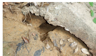
写真-6 洪水吐左岸側取付け部 (落水後 2020. 8. 30)
