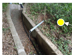
写真-3 パイプの挿入 (H28.8.17, 水土里ネット島根)
