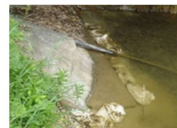
写真-2 漏水対策 (H28.6.3, 水土里ネット島根)
