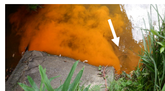
写真-5 パイピングホールの確認 (2020. 7. 31)
