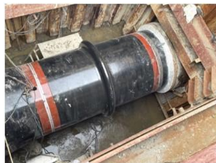
図 1 大変位吸収鋼管
