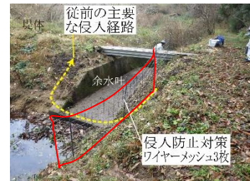
図 5 簡易な侵入防止対策 Easy Countermeasure to prevent Invasion
