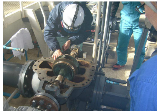
写真-1 オーバーホール状況
