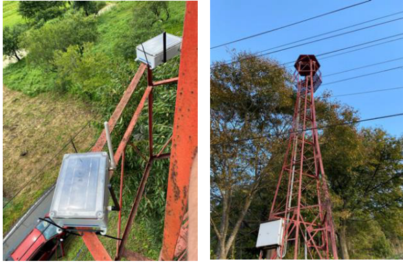
図3 火の見櫓に設置された基地局（2台）
