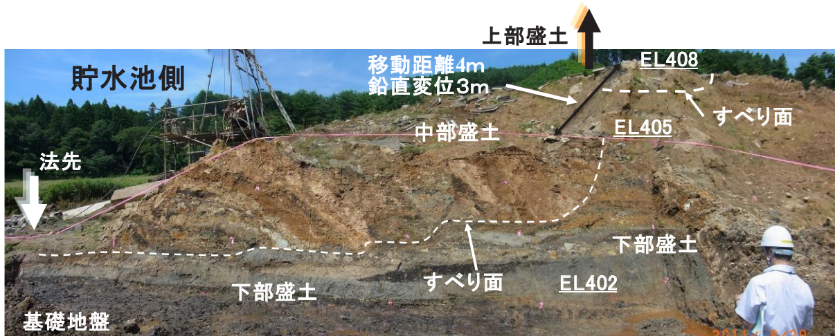
Fig. 2 堤体すべりの状況を示す断面
