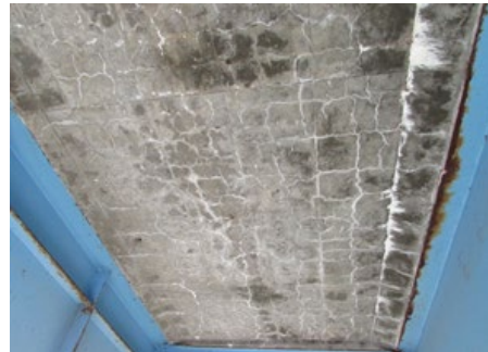
図-2 損傷度評価を試みた RC 橋梁 Fig. 2 Target of evaluation (RC bridge)
