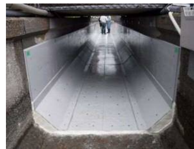
b) 補修水路状態
