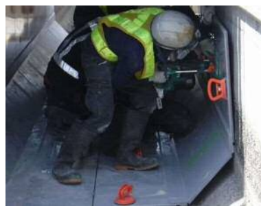
a) ユニット材取付け状況
