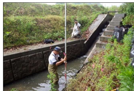
図 2 土砂堆積状況調査 Fig.2 Investigation of sediment deposit
