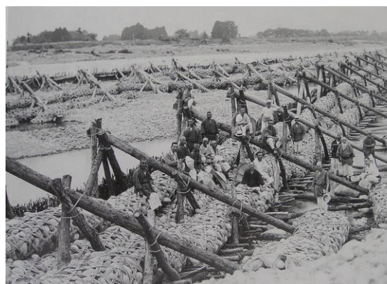
写真1 舟戸口用水取水施設（昭和11年）
