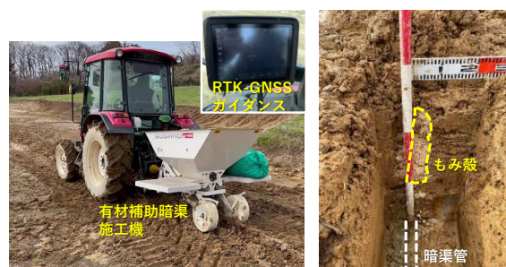
写真 1 暗渠疎水材の再充填
