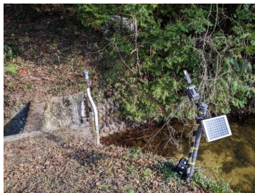
写真-1 ため池遠隔監視システム
