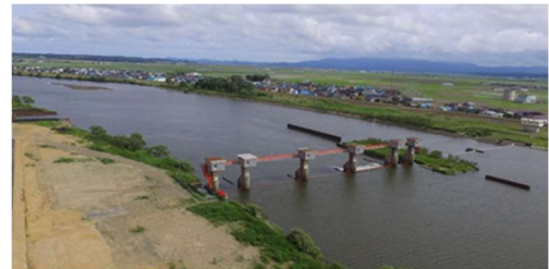
写真-1 改修前の芦野頭首工
