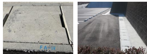
写真-2 PCa製品の設置状況
