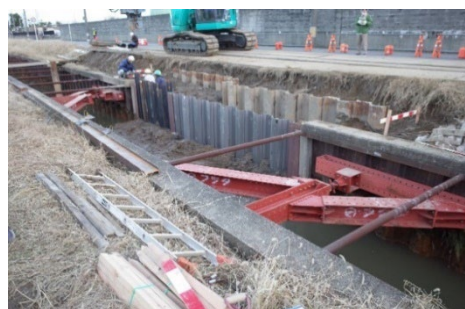
図-1 大石排水路での試験施工状況
