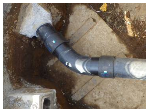
写真3 EF継手によるベンド部の形成
