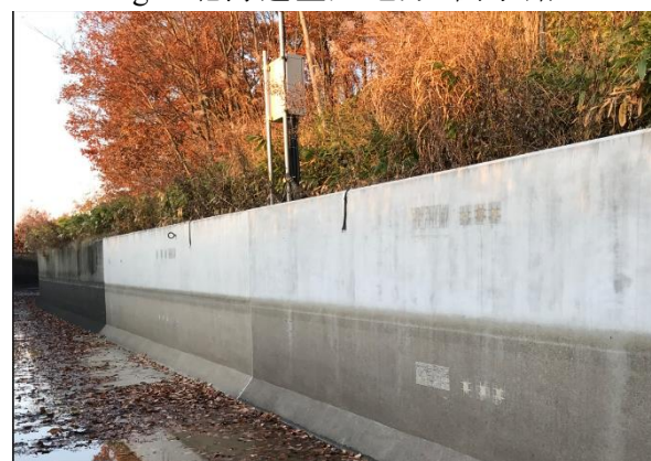
Fig-2 補修後の壁面
