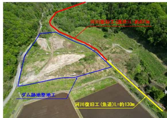
写真-2 ダム撤去後 (R5 時点)
