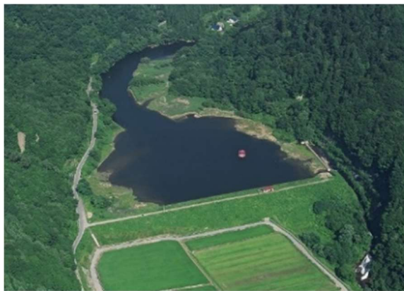
写真-1 ダム運用時 湛水状況
