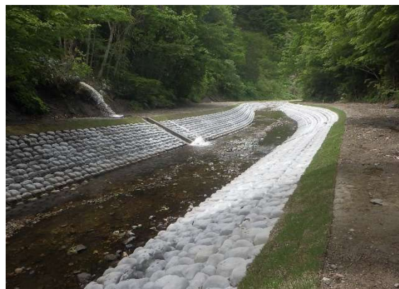
写真-4 護岸整備状況
