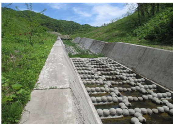
写真-3 魚道整備状況
