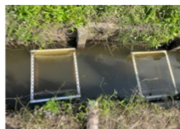
図-1 水路に設置した様子
